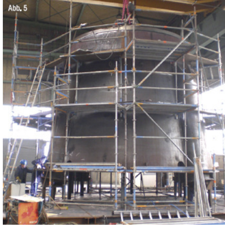
Rüzgar türbinlerinin gövdesindeki kaynak dikişlerinde yorulma dayanımının yükseltilmesi için HiFIT yönteminin kullanımı
