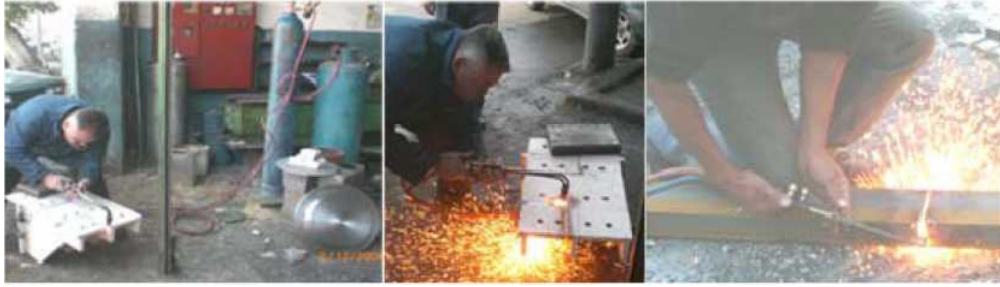
Resim 3) Oksi - Asetilen kaynağı ile metal parçaların kesilmesi
