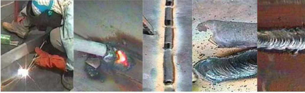
Resim 7. Elektrot kaynağı uygulaması
