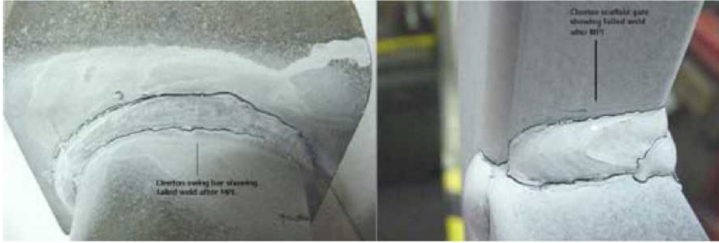
Resim 2) Kaynaklı birleşimlerde hasar oluşumları
