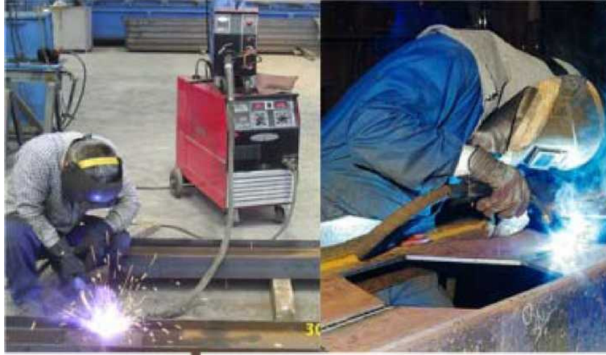
Resim 13) MIG Elektrik Ark kaynağı uygulaması
